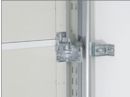
Seitliche Ankerbefestigung
